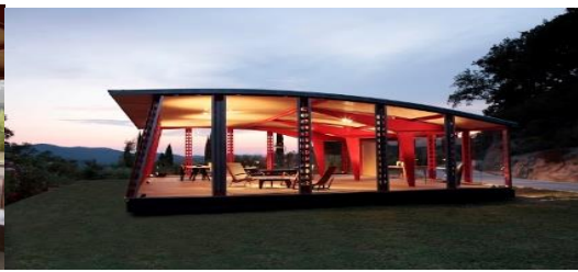
شكل (١) نموذج للمنشآت المؤقتة ( فصل دراسي متنقل ) Jean Prouvé, Temporary School of Villejuif بناء خفيف الوزن يمكن تجميعه بسرعة، وسوف تصلح ليجري تفكيكها وإعادة نصبها في أماكن أخرى المواصفات. ( الدعائم صفائح من الفولاذ ، سقف الخشب الرقائقي المنحني) .
